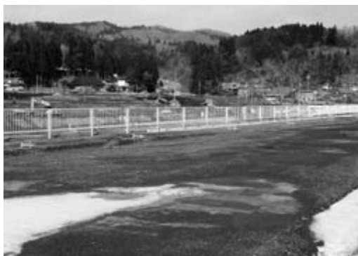
地域と地域を結ぶ市道の整備を進めます(写真は市道大原波民線)
