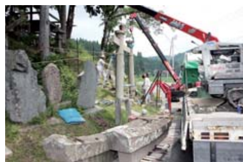
鳥居や石段などが破損した駒形根神社。急ピッチで修復が行われました
