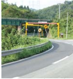
県道一関大東線(流矢地区)
