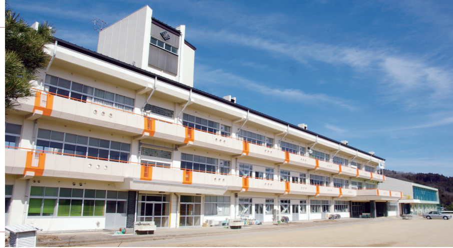
薄衣、門崎の両小学校が統合して誕生した川崎小学校
