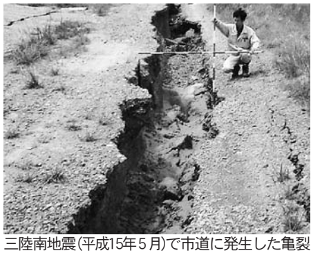
三陸南地震(平成15年5月)で市道に発生した亀裂
