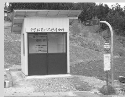
完成した待合室
