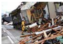
早めの耐震診断を(能登半島の倒壊状況)
