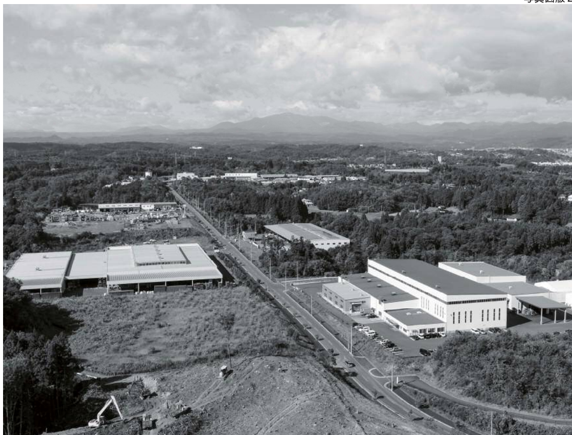
1 調査区より栗駒岳を望む(東より)
