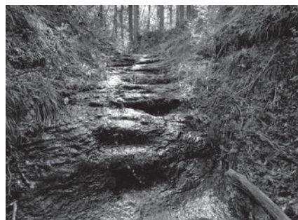
写真8 階段状に削られた岩盤
