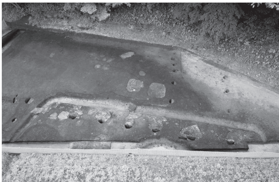
15 掘立柱建物2・3完掘
