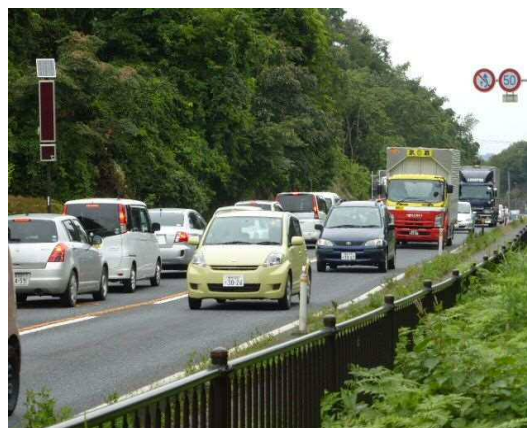
国道4号：平泉町との境付近
