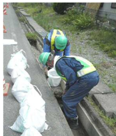
側溝土砂の除去作業 (緊急対応分)
