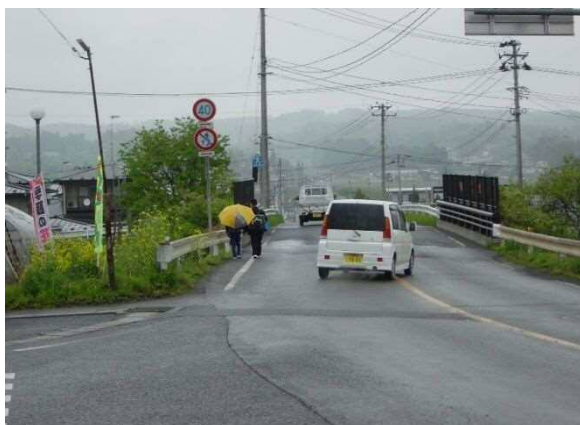
県道若柳花泉線：J R 東北本線跨線橋
