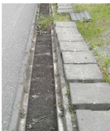
側溝に堆積した土砂
