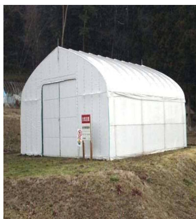
汚染牧草一時保管施設
