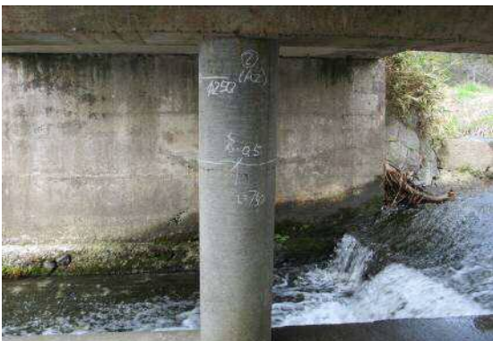
下部工(パイル橋脚のひびわれ)
