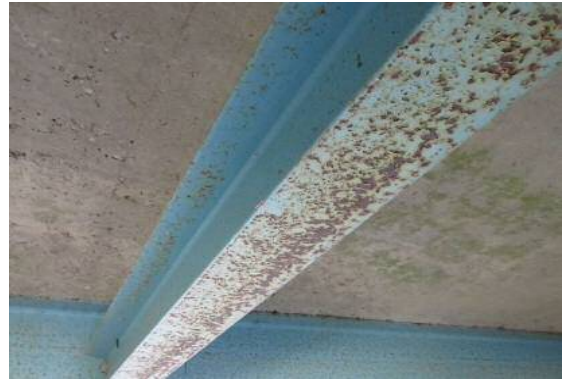
主桁の腐食
