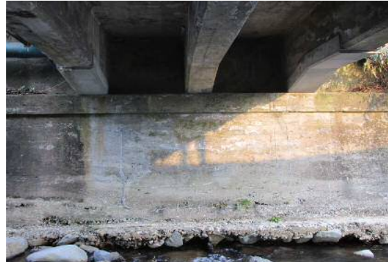
基礎の洗堀(河床低下)
