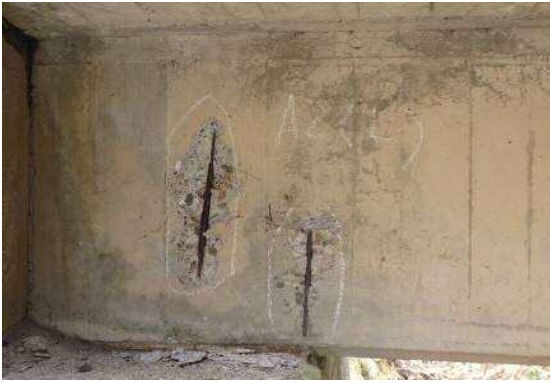
主桁の鉄筋露出
