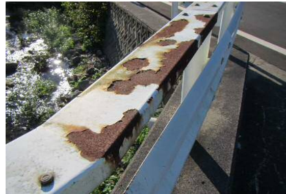
防護柵の腐食
