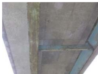
新城館橋 供用年数38年
