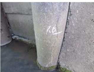
機場橋 供用年数55年
