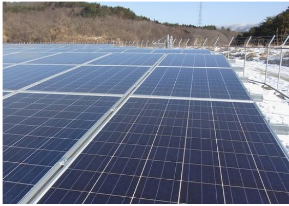
写真① 一関市東山太陽光発電所
