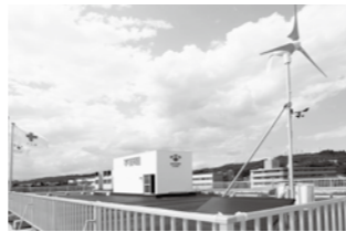
当社屋上の風力発電機
