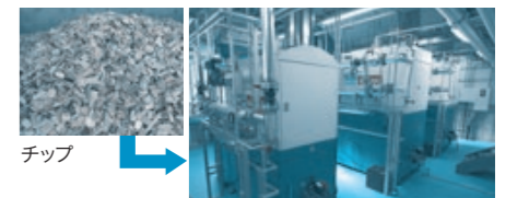
県産チップボイラーにより温水供給
