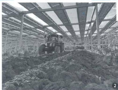
② 農業用トラクターを稼働させるために、発電パネルを乗せる柱を高くしています。見学会時には、すでに大麦がまかれていました。来年の収穫が楽しみです。（写真は大麦播種前の耕起時）
