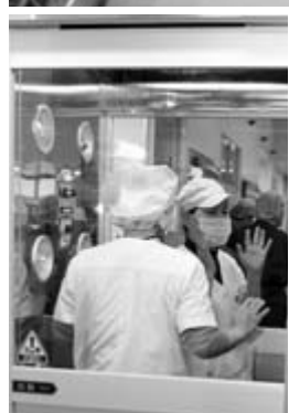
調理室には、エアシャワーでほこりを落とし入室します
