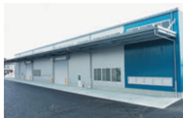
新設した第5工場
