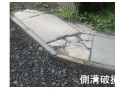
側溝破損
