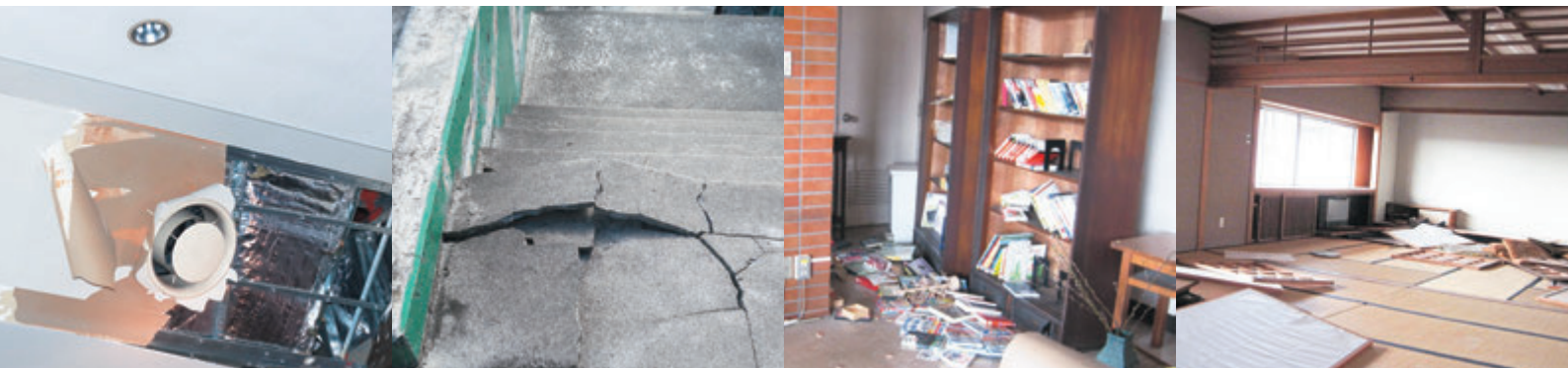
映画館「一関シネプラザ」天井
