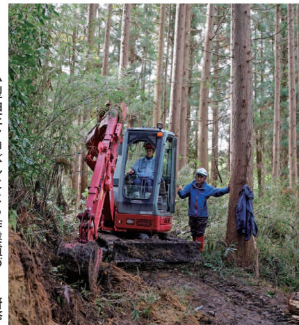
小型油圧ショベルによる作業道づくり研修
