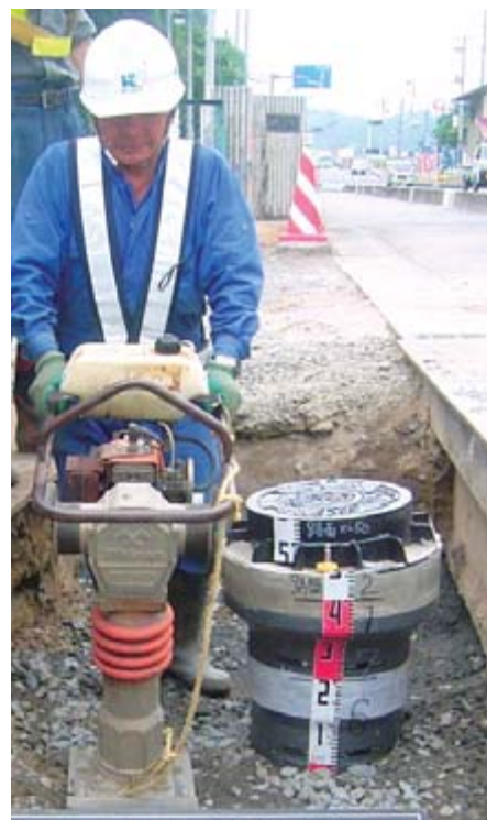
千厩地域で実施している下水道工事
