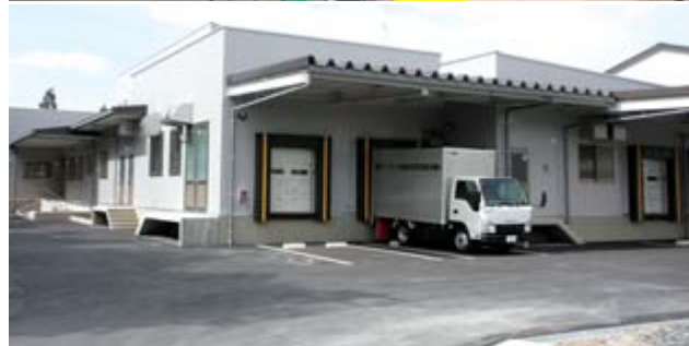
上 関係者が拍手で第1便の出発を見送りました 中 ドライシステム、オール電化の調理室内部 下 鉄骨造り2階建てのセンター外観
