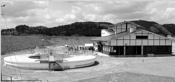
完成した浄化センター。汚水に酸素を供給・かくはんし、微生物を発生させて浄化するオキシデーションディッチ(左)と管理汚泥棟(右)
