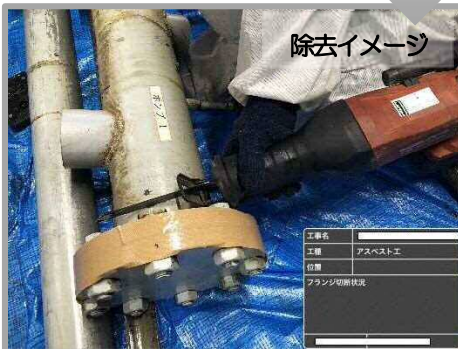
配管断熱材接合部のアスベスト除去
