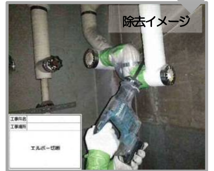
配管エルボ部のアスベスト除去
