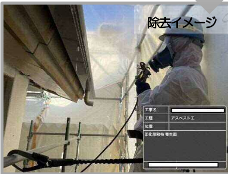
仕上げ塗材のアスベスト除去 (隔離養生)
