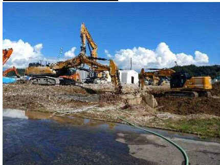
【土間基礎解体】
