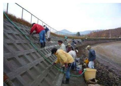
写真4 コンクリートブロック・目地等補修（長野県）
