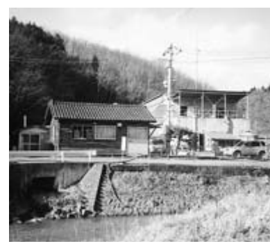
宮田浄水場（千厩地域）
