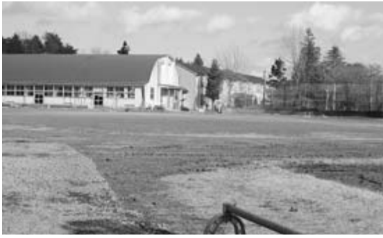
現真滝中のグラウンド(写真)に建設される統合中学校
