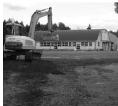
建設がはじまる統合弥栄・真滝中学校
