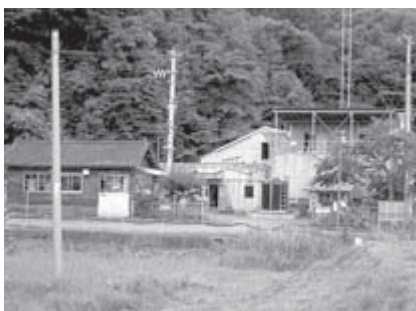
老朽化した千厩宮田浄水場
