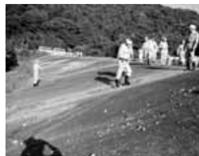
市政調査会による災害調査（金流川堤防）
