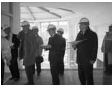
建築中の一関東中学校
