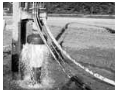
新たな水源の調査（薄衣字上巻地内）
