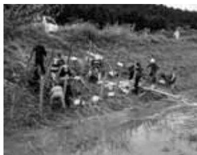
漏水箇所の水防工法活動
