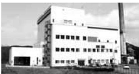
ごみ焼却施設
