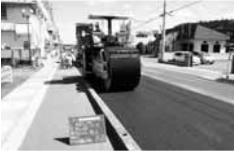
道路維持補修工事
