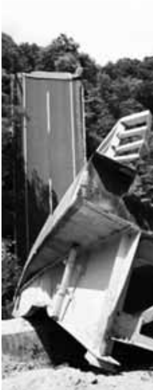
落橋した祭時大橋
