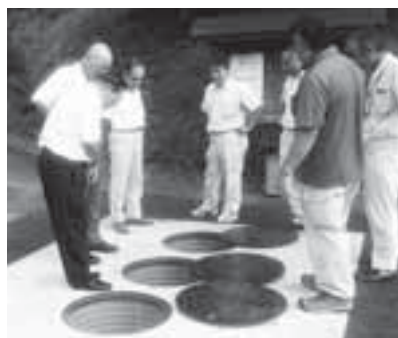
浄化槽（盛岡市玉山区）
