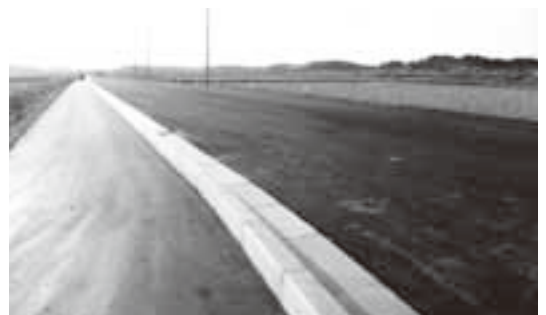
平成25年度末完成予定の一般国道342号 花泉バイパス
