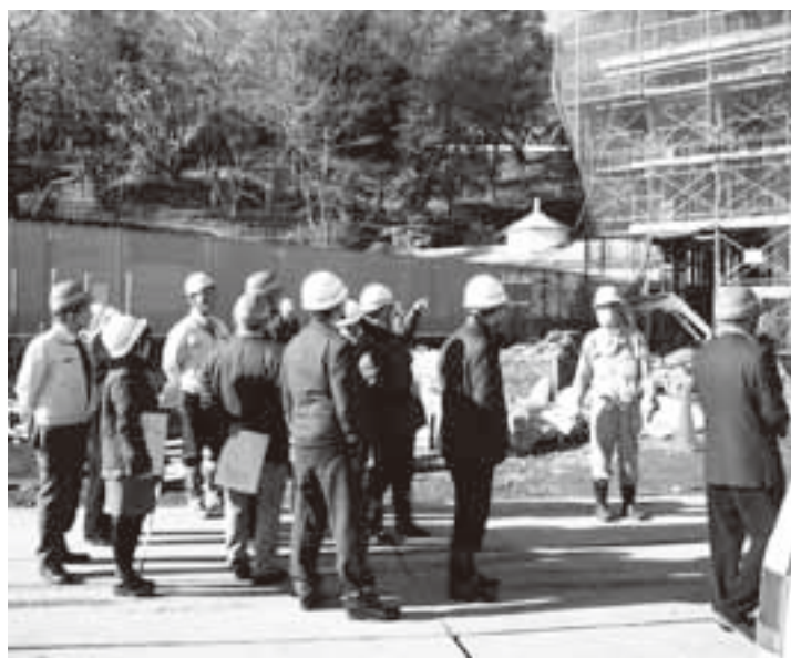
中里小学校体育館建設現場
