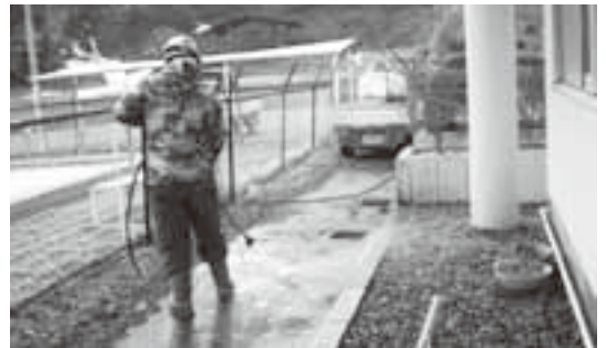
放射能除染作業現場
