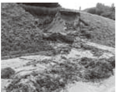
大雨災害で崩れた土手
