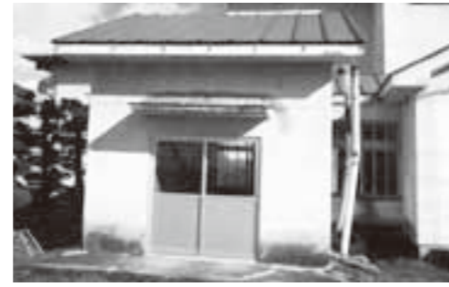
改築が待たれる桜町中の屋外トイレ
