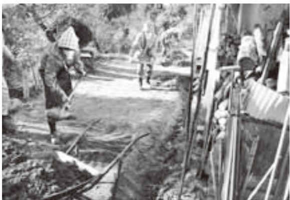
千厩花貴自治会の除染作業
