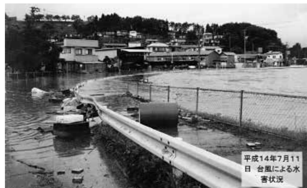
平成14年7月千厩橋付近の洪水状況
