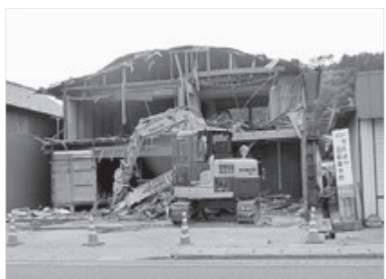
解体される住宅
