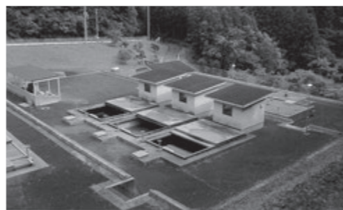
上水道整備が待たれる室根地域
