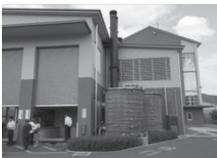
真庭支庁舎 木質バイオマス発電施設
