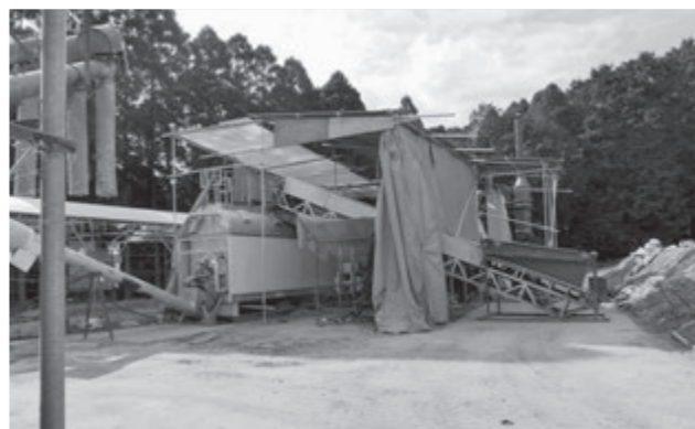
千葉県山武市 石橋牧場廃棄物処理
