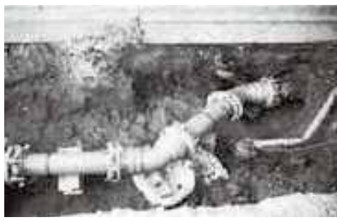
老朽化した水道管の更新
