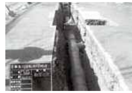
配管布設工事の様子
