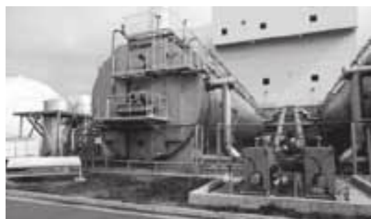
バイオメタンガス発酵槽
