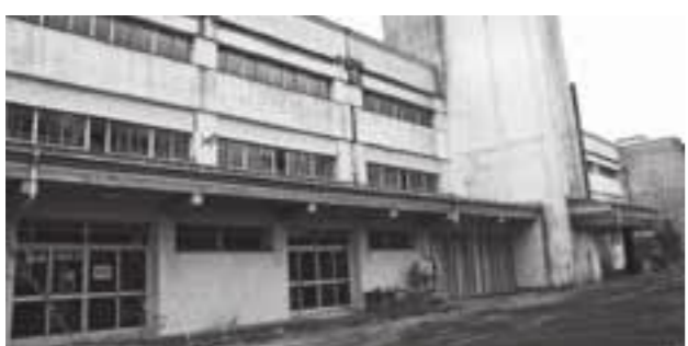
解体予定の旧大原中学校
