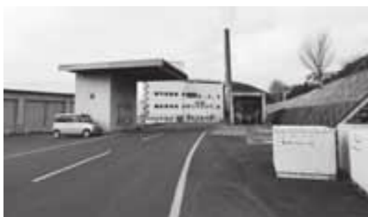
老朽化した一関清掃センター
