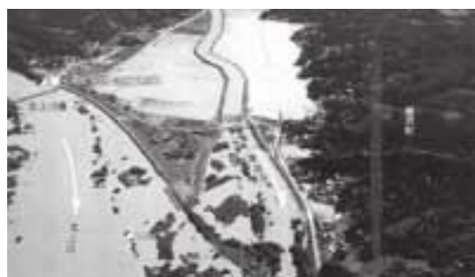
平成14年7月の黄海地区の洪水状況
