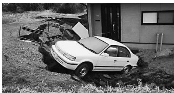
萩荘境ノ神地区の陥没現場
