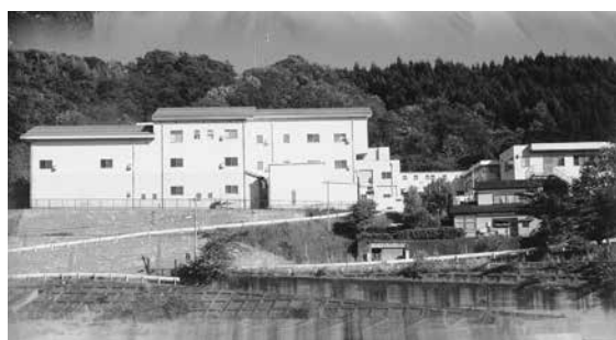
委託予定の脇田郷浄水場
