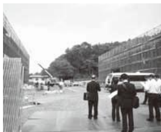
建設中の新貸し工場
