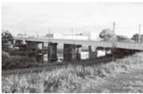
急がれる磐井川JR橋梁架けかえ工事
