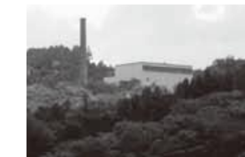
市内の焼却場
