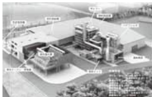
真庭バイオマス発電所
