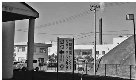
一関清掃センター（狐禅寺字草ヶ沢）
