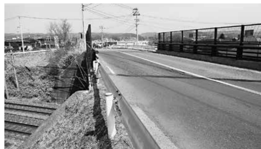
早期に望まれる跨線橋への歩道設置
