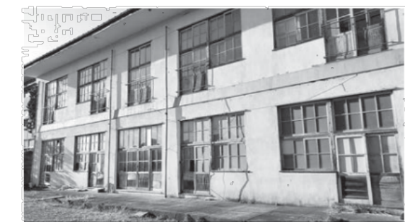
昭和37年建設の興田中学校旧校舎（現在倉庫）
