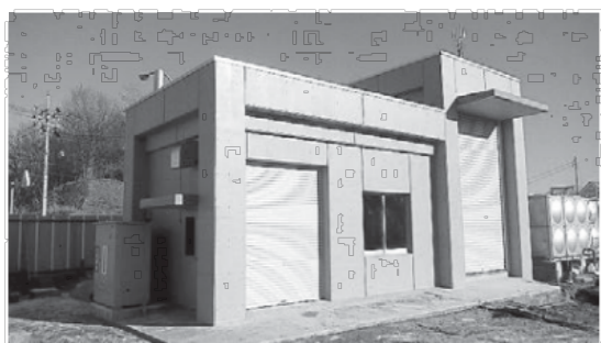
千厩小学校に導入されたチップボイラー
