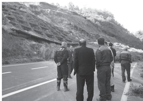
市道南沢下宇津野線ののり面崩落現場
