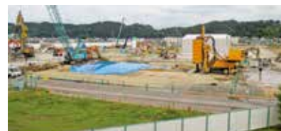
解体と土壌汚染除去が進むNEC跡地
