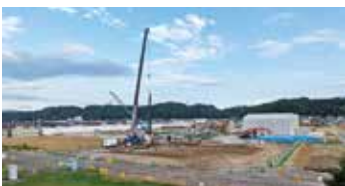
建物の解体が進むNEC跡地
