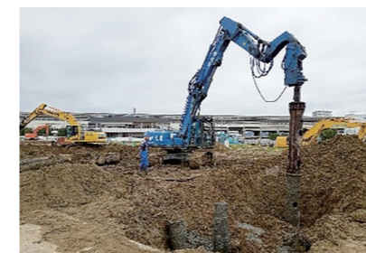
工事が進むNEC跡地
