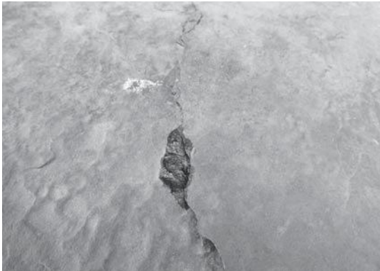
3 剥離部分の保存処置③
