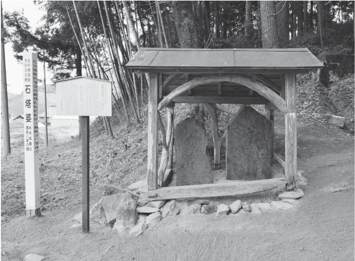
1 調査完了後復旧覆屋 正面
