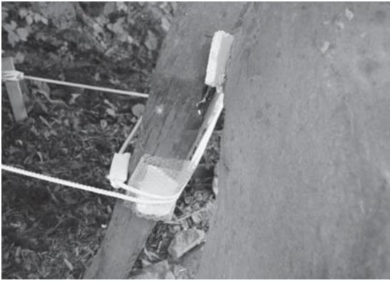
1 平成28年3月応急処置状況③
