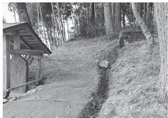
5 排水路開渠整備状況
