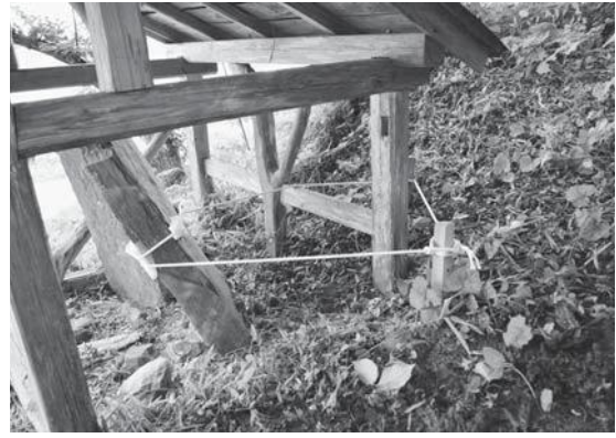
2 平成28年3月応急処置状況④
