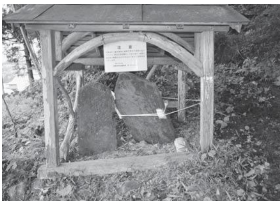
4 平成28年3月応急処置状況①
