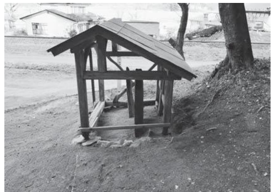
3 復旧覆屋 右側面
