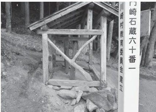
2 復旧覆屋 左側面
