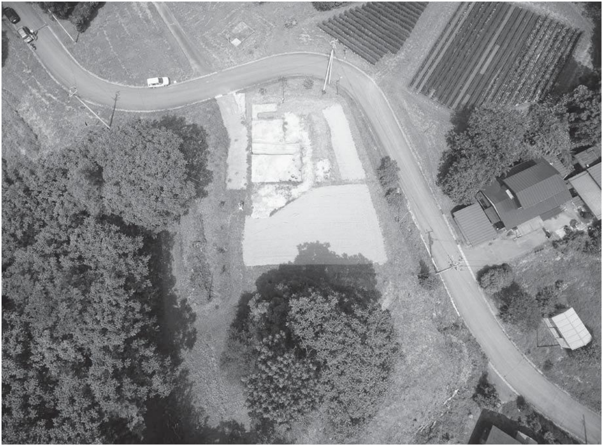
1 猫館遺跡全景（南西から、無人航空機による空中撮影）
