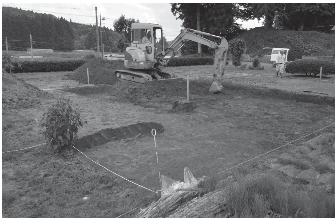
試掘調査の状況
