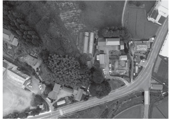
2. 調査区近景（空中写真）
